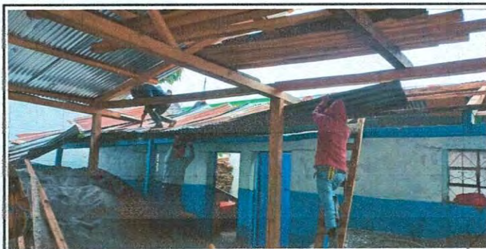
Foto 5: cambio de bajadas de agua y canales
