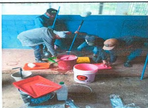
Foto 11: Pintura de muros exteriores
