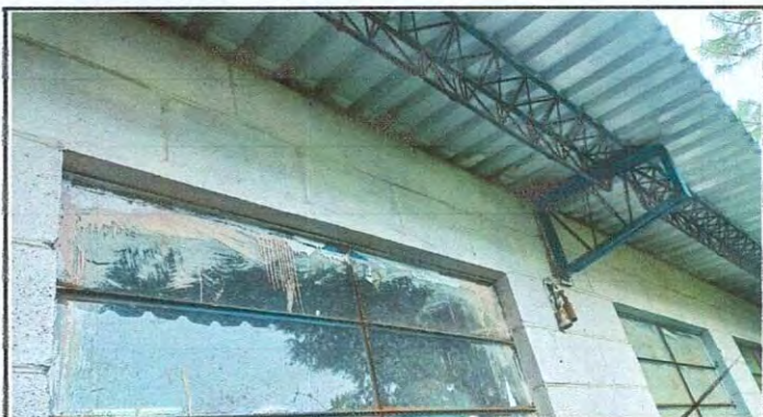
Foto 3: cambio de vidrios en ventanales.
