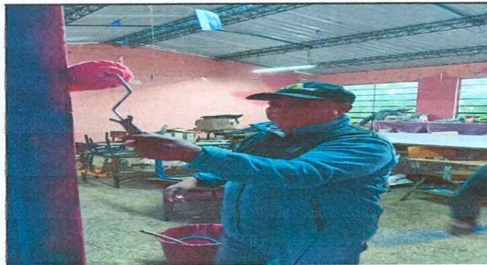
Foto 10: Pintura en muros interiores
