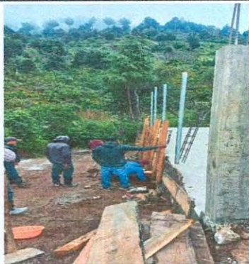
Foto 7: Reparación de tubo y malla galvanizada
