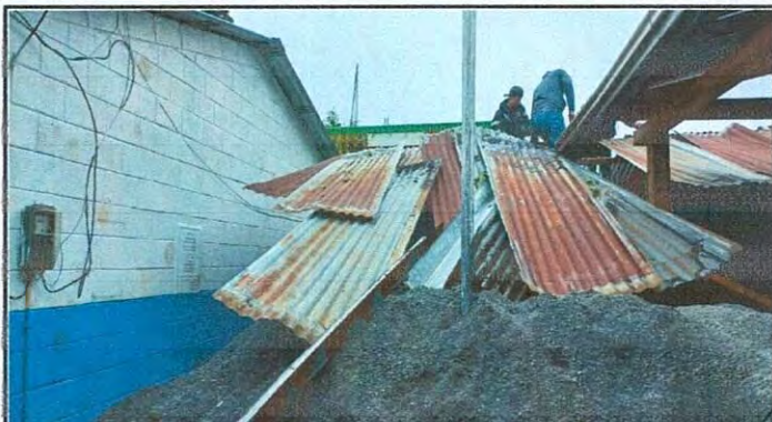
Foto1: Cambio de lamina a lamina troquelada por deterioro. Modulo cocina.
