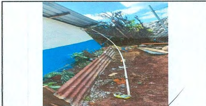
Foto 6: cambio de tubería principal de chorro de pila
