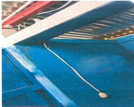
Foto 8: Reparación de sistema eléctrico
